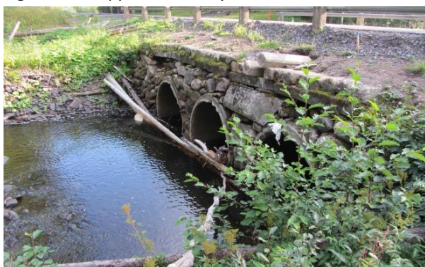
Figur 81. Uppströms vy av bro.
