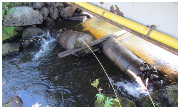
Figur 21. Fördämning av igen gjutna ståltunnor.
