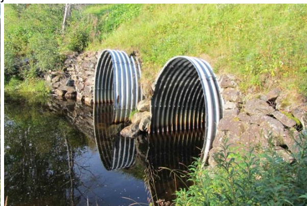
Figur 118. Nedströmssidan av vägtrummorna (A).
