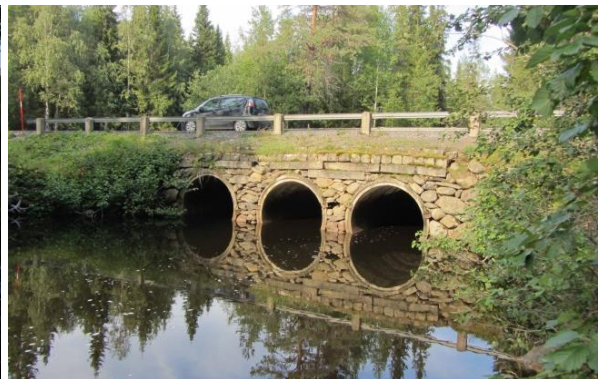
Figur 80. Valvbro med betongtrummor (objekt 1).
