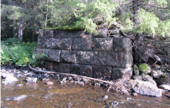
Figur 83. Gammalt brofäste av kilsten (objekt 2).
