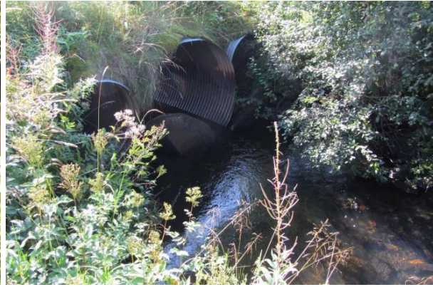
Figur 28. Vägtrummor vid punkt K. Uppströms vy.
