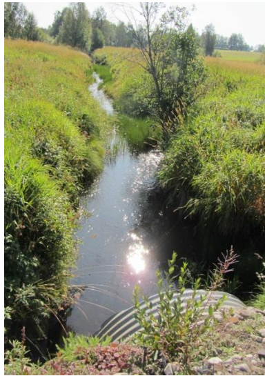
Figur 30. Vy uppströms vägtrummor av de två fåror som rinner samman ovan vägen vid punkt K.
