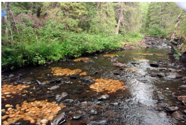
Figur 11. Lekbottnar anlagda strax ovan punkt A. Vy från bäcknivå respektive uppifrån.
