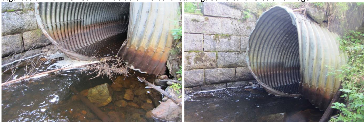
Figur 31. Vänster vägtrumma före respektive efter rensning.
