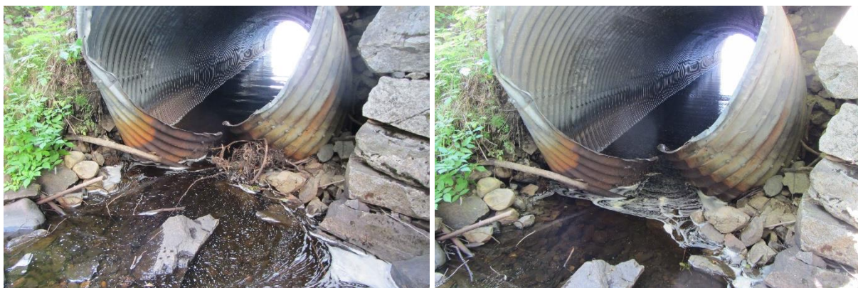
Figur 32. Höger vägtrumma före respektive efter rensning.
