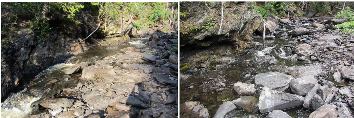
Figur 27. Översta delen av Gamm-Karbäcken nedan vattenfallet, före respektive efter åtgärd.
