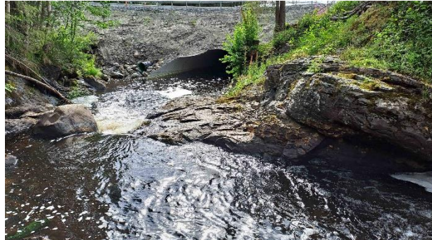
Figur 7. Vägtrummorna utbytt mot en halvtrumma 2023.
